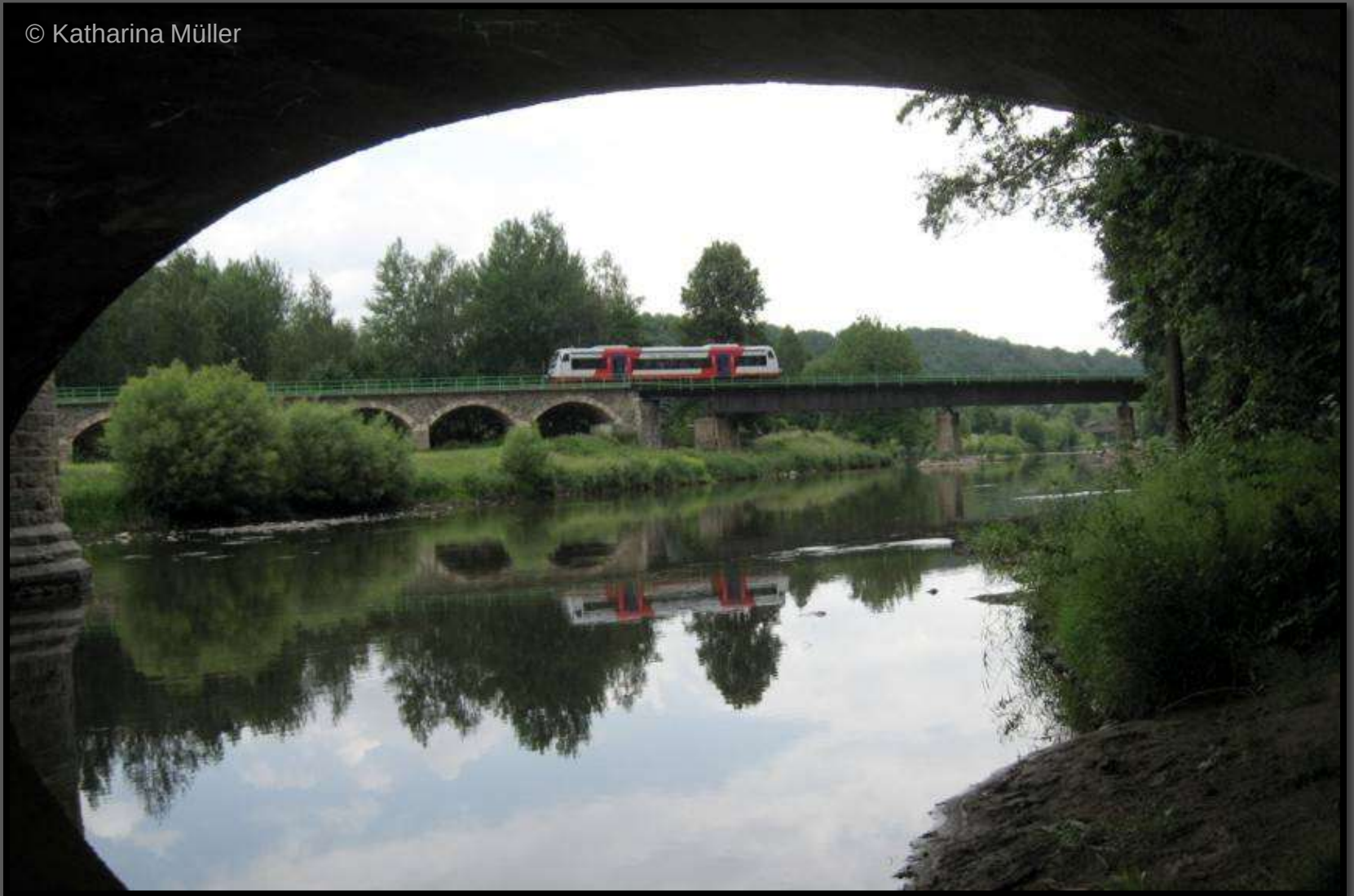
Bahnviadukt und Brücke der City-Bahn
